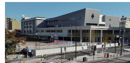
▲PFI事業による学校校舎整備(大分市立金池小学校)
