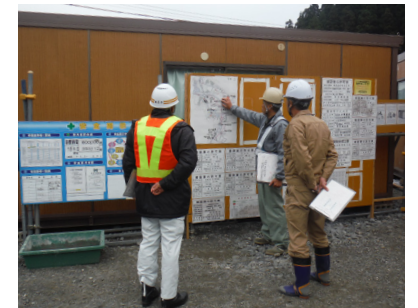
▲施工現場における工事監督支援
