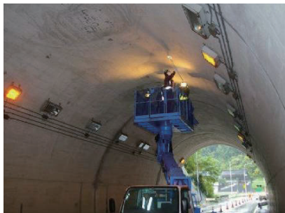
▲トンネル点検
