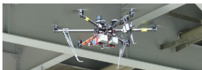
▲UAVを用いた橋梁点検
