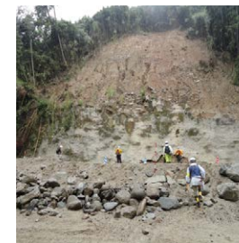
▲崩壊地の現地調査状況
