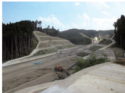
▲施工中の新名神高速道路 (新四日市JCT~菟野) <2019年3月開通>
