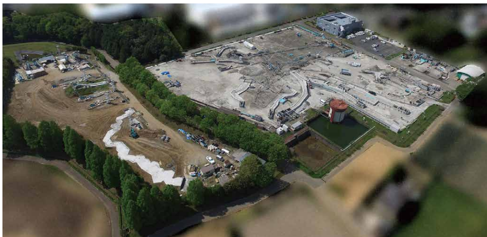
▲つくば研究センター内実験施設
