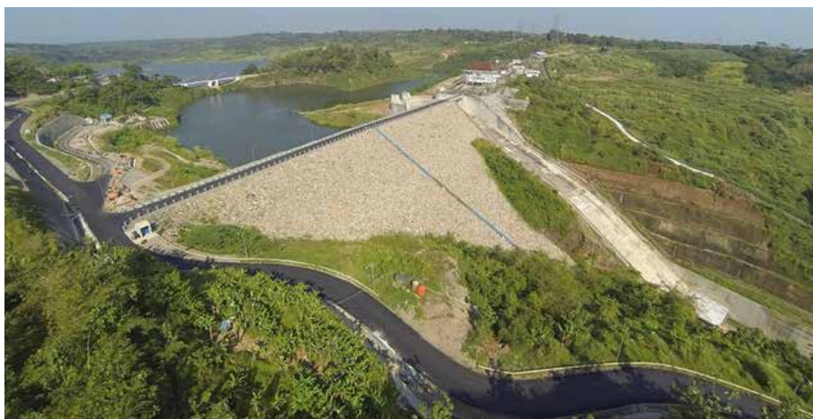
▲「インドネシア国スマラン地域総合水資源・洪水管理計画」で完成したジャティバラダム (高さ74m)
