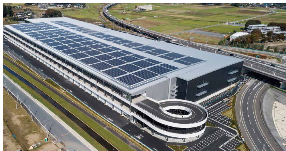
▲茨城県五霞町 五霞インターチェンジ周辺土地区画整理事業
