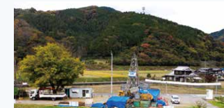
▲調査現場遠景（ドローン空撮）
