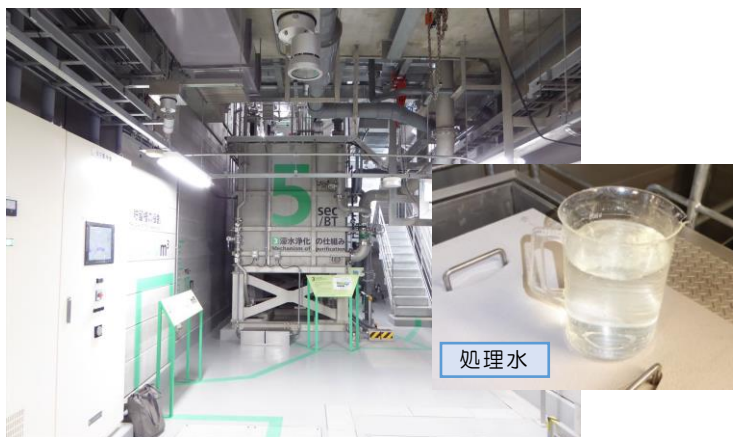
皇居外苑濠水浄化施設 (りん除去によるアオコ等水質改善)
