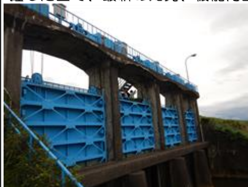
法柳樋門（開閉機更新） （北陸地方整備局）
