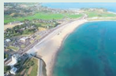
東日本大震災で被災した宮城県仙沼市の大谷海岸防潮堤(再生後)
