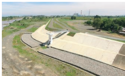
完成した水門
