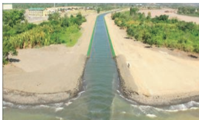
河口処理された放水路
