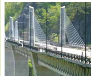
不動大橋 (旧称：ハッ場ダム湖面2号橋) 世界初の橋梁形式・PC 複合トラスエクストラード ス橋。通常のコンクリートウェブを軽量の鋼管トラス に置き換えたハイブリッド構造で、エクストラード ス橋にこれを採用したのは世界初となる。(2010 年度土木学会田中賞作品部門受賞)
