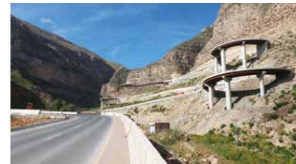
急斜面に建設された曲線鋼箱桁橋梁
