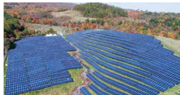
釜石檜ノ木平太陽光発電所
