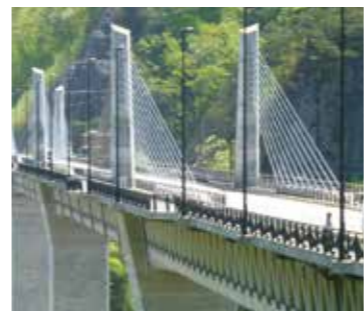
不動大橋 (旧称：ハッ場ダム湖面2号橋) 世界初の橋梁形式・PC 複合トラスエクストラード ス橋。通常のコンクリートウェブを軽量の鋼管トラス に置き換えたハイブリッド構造で、エクストラード ス橋にこれを採用したのは世界初となる。(2010 年度土木学会田中賞作品部門受賞)
