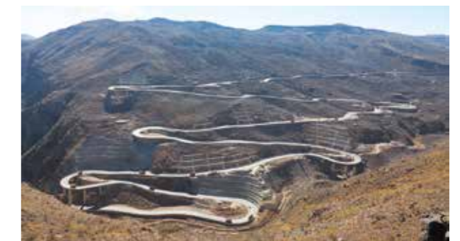
のり面安定工法による道路防災対策
