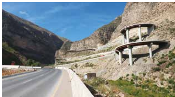
急斜面に建設された曲線鋼桁橋梁
