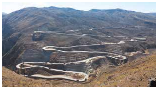
のり面安定工法による道路防災対策
