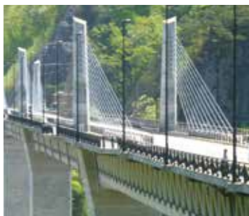
不動大橋（旧称：ハツ場ダム湖面2号橋） 世界初の橋梁形式・PC 複合トラスエクストラドー ズド橋。通常のコンクリートウェブを軽量の鋼管トラス に置き換えたハイブリッド構造で、エクストラドー ズド橋にこれを採用したのは世界初となる。（2010 年度土木学会田中賞作品部門受賞）
