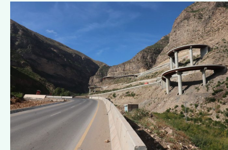
パキスタン国 国道70号線改良工事
