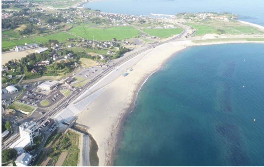
宮城県大谷海岸 砂浜再生まちづくり事業(防潮堤の詳細設計を担当)
