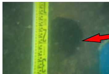
鋼部材の損傷例（開孔）
