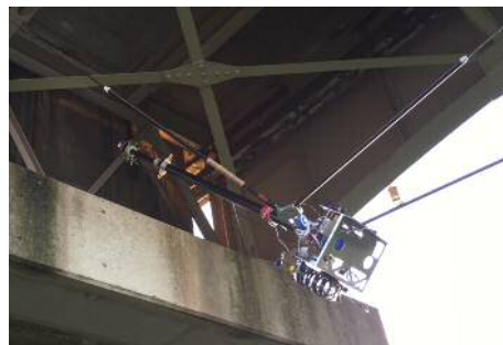
図6 桁端狭隘部の点検実施状況
