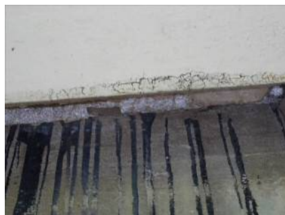
図7 伸縮装置下面の確認状況
