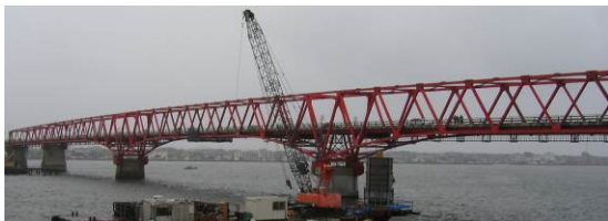
既設橋の詳細調査
