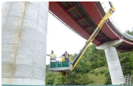
橋梁点検車による橋梁点検
