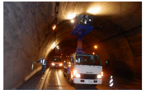
高所作業車によるトンネル点検
