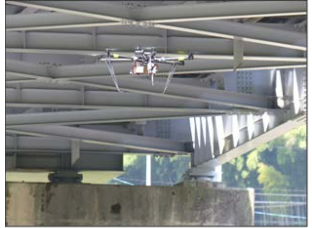
橋梁桁下撮影状況
