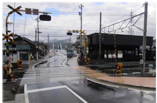
踏切部への歩道設置拡幅の事例
