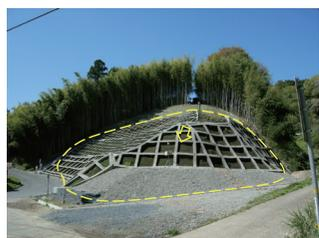
▲地すべり対策施設の計画・設計(法枠・杭工)
