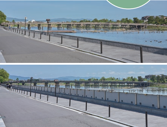
上：平常時（止水壁格納時） 下：洪水時（止水壁起立時）
