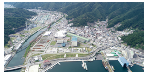
釜石東部地区空撮（2019年7月撮影）
