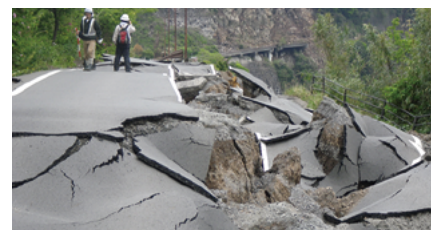
熊本地震直後の道路被災状況（2016年4月）
