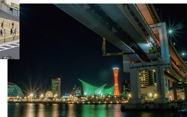
▲国道2号 浜手バイパス 橋梁点検
