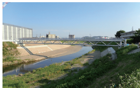
▲大門橋下流水管橋 (小畑川) 逆三角トラス構造
