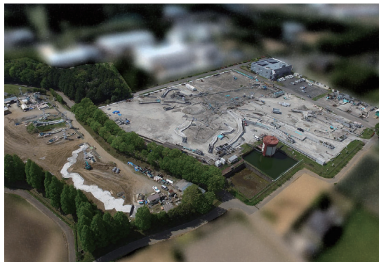
▲つくば研究センター内実験施設
