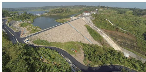
▲「インドネシア国スマラン地域総合水資源・洪水管理計画」で完成したジャティバラダム(高さ74m)
