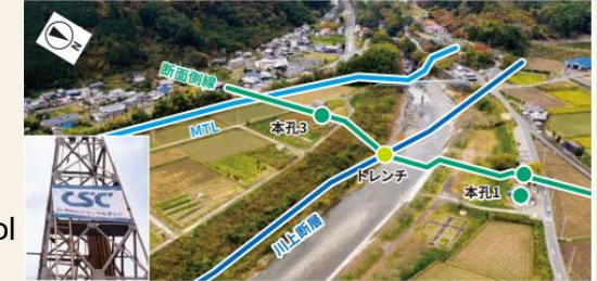
▲中央構造線近傍の活断層調査地全景(ドローン空撮)
