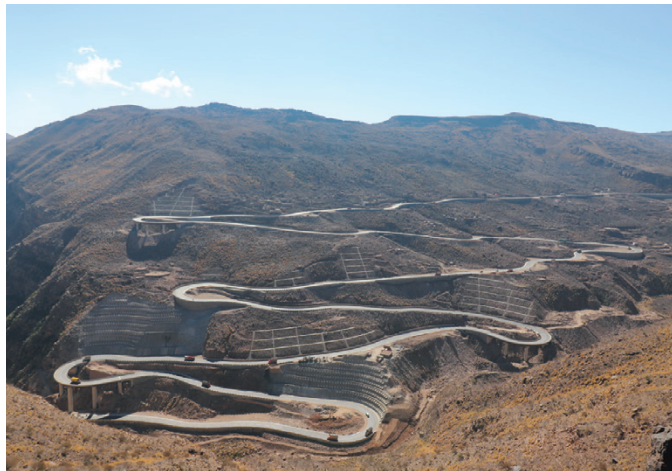
のり面安定工法による道路防災対策
