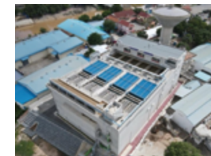
完成した上水道施設
