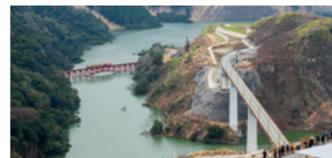
試験湛水時の湛水状況 （写真提供：国土交通省熊本河川国道事務所河川管理課）
