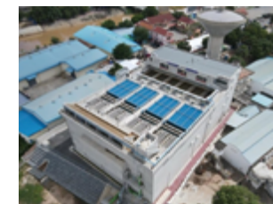
完成した上水道施設
