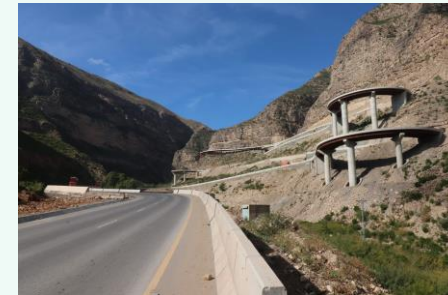
パキスタン国 国道70号線改良工事
