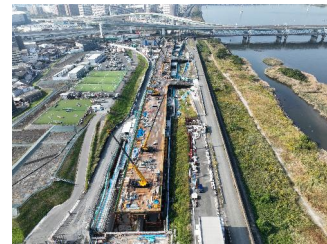
堤防一体型の道路工事に伴うCM
