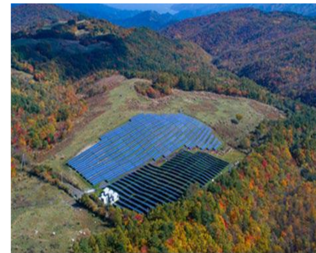
太陽光発電事業 (釜石檜ノ木平太陽発電設備)
