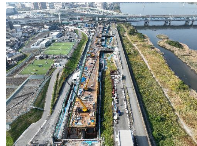
堤防一体型の道路工事に伴うCM
