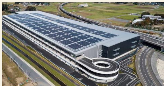
▲茨城県五霞町五霞インターチェンジ周辺土地区画整理事業 写真提供：日本GLP株式会社「GLP園央五霞」
