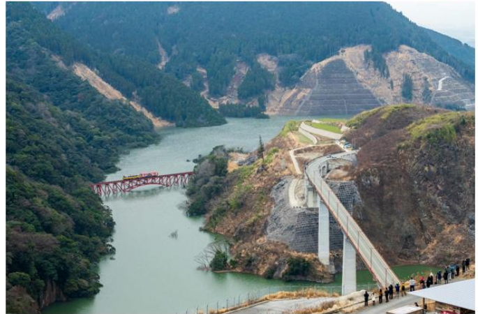
写真提供：国土交通省 熊本河川国道事務所 河川管理課
