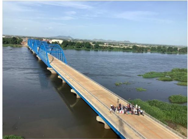
完成した「Freedom Bridge」
