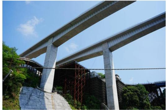
新東名高速道路「新皆瀬川橋」
