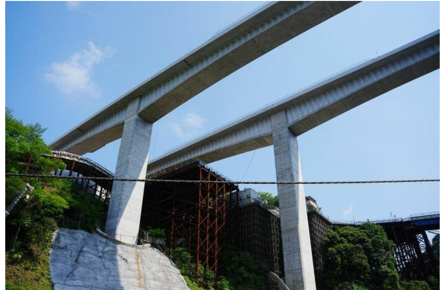
新東名高速道路「新皆瀬川橋」
