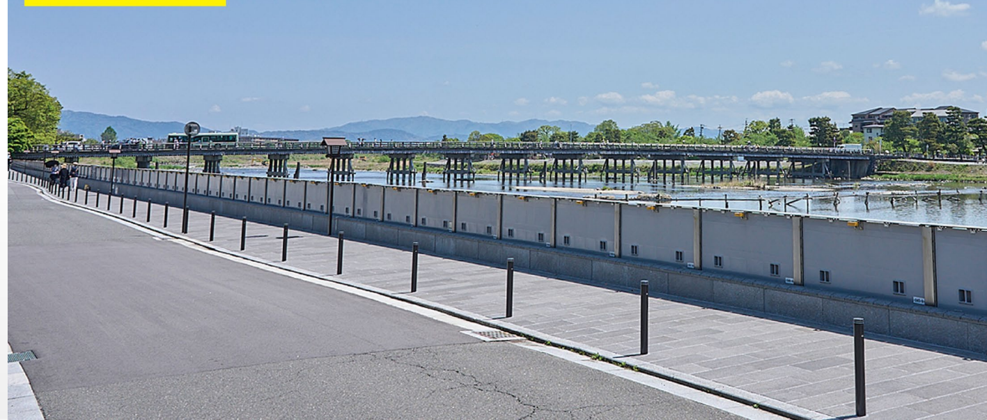
洪水時（止水壁起立時）
