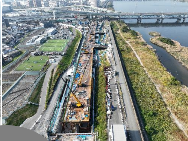
堤防一体型の道路工事 に伴うCM
