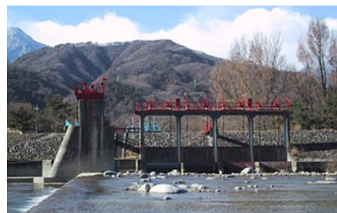
写真-1 徳島堰の全景
