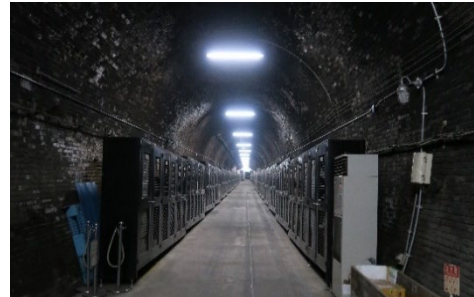
写真-5 旧深沢トンネル
