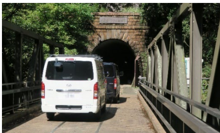
写真-4 旧大日影トンネル
