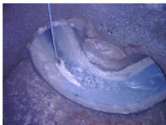
図4-3 暗視カメラで撮影した管渠内の状況
