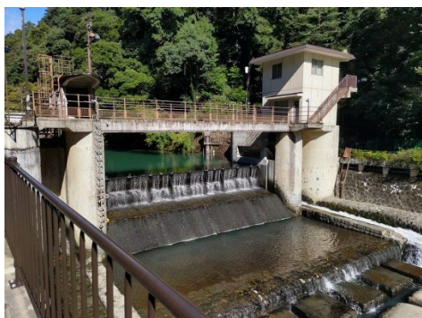
写真-3 山崎発電所取水堰（土木学会推奨土木遺産）
