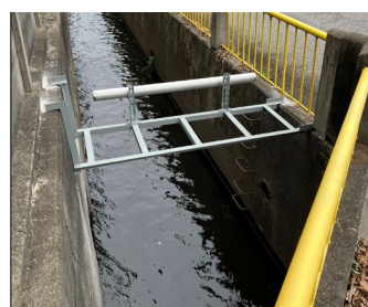
図3-3 排水路 (パイプにカメラ設置)
